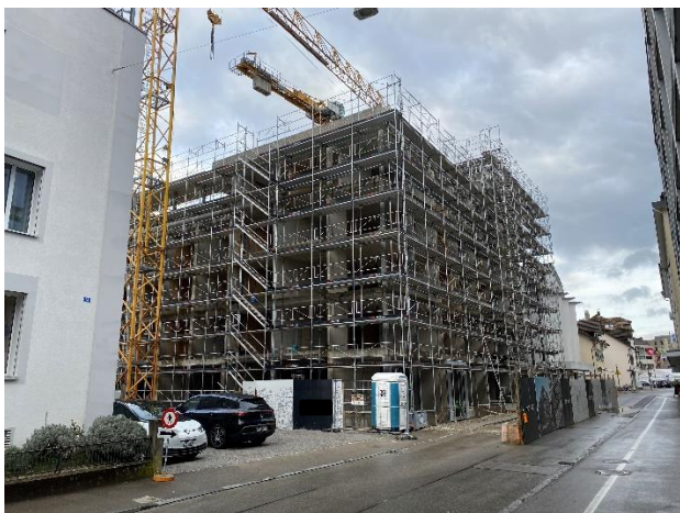
Baustelle am 13. März 2023
