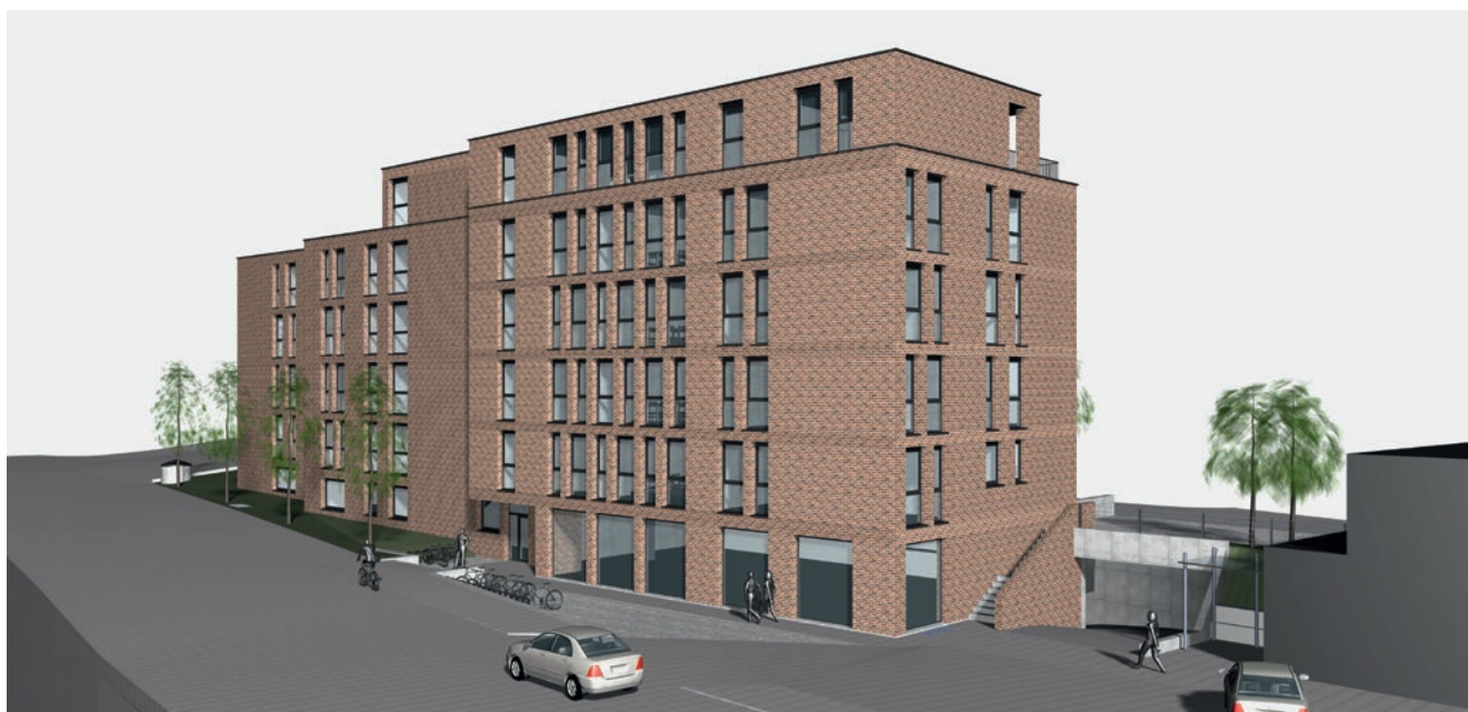
Blumenstrasse 2 und 4, 9014 St. Gallen-Bruggen, 17 Mietwohnungen und 2 Gewerbeflächen (im Bau)
