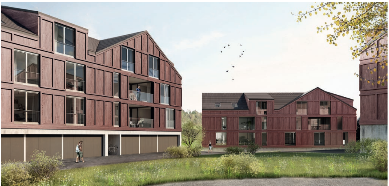
«Am Mattenbach», 9035 Grub AR, 24 Mietwohnungen in Holzbauweise (im Bau)
