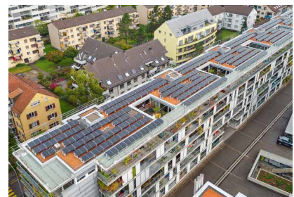
Energetische Sanierung Dennlerstrasse 25–39 in Zürich: Sanierung Elektroanlagen, Sanierung Flachdach und Bau einer Photovoltaik-Anlage mit 124 000 kW, Erstellung e-Mobility (Siemens) u.a.m.
